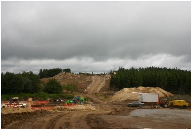
Chantier éolien industriel au col de Fontfroide (Hérault)
