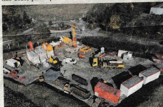
Le forage de Satigny est le plus grand réalisé par les SIG. -111
