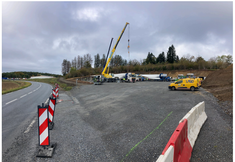
Un chantier sans autorisation environnementale à St-Amans-Valtoret
