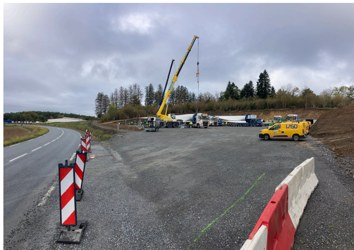
Chantier démarré illégalement pour la centrale éolienne de St Amans-Valtoret
