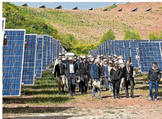
La centrale solaire de Bédarieux, lors de son inauguration en 2017. Elle s'étale aujourd'hui sur 25 hectares. (P3)
